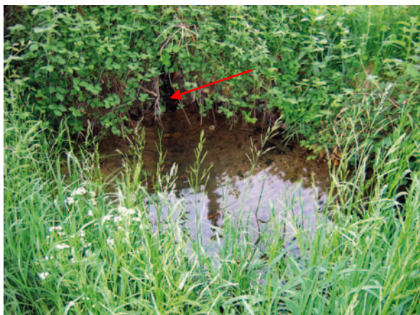
Fig. 3 > Drain agricole débouchant dans une gouille en berge du cours d'eau
