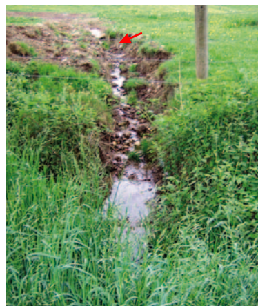
Fig. 4 > Drain agricole débouchant dans une tranchée creusée
