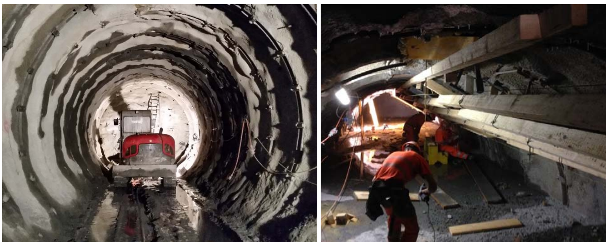
Ausbruch und Sicherung mit Bogen
