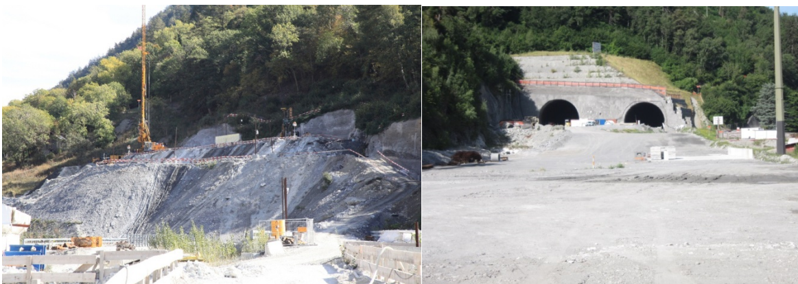
Bild 10/11: Stabilisierungsmassnahmen im Oktober 2014 zur Sicherung des Portals des TURI
