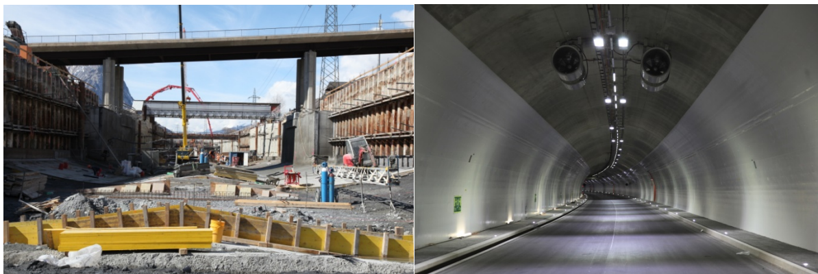
Bild 8: Bau des Gedeckten Einschnittes Turtmann (GETU) im April 2013.
