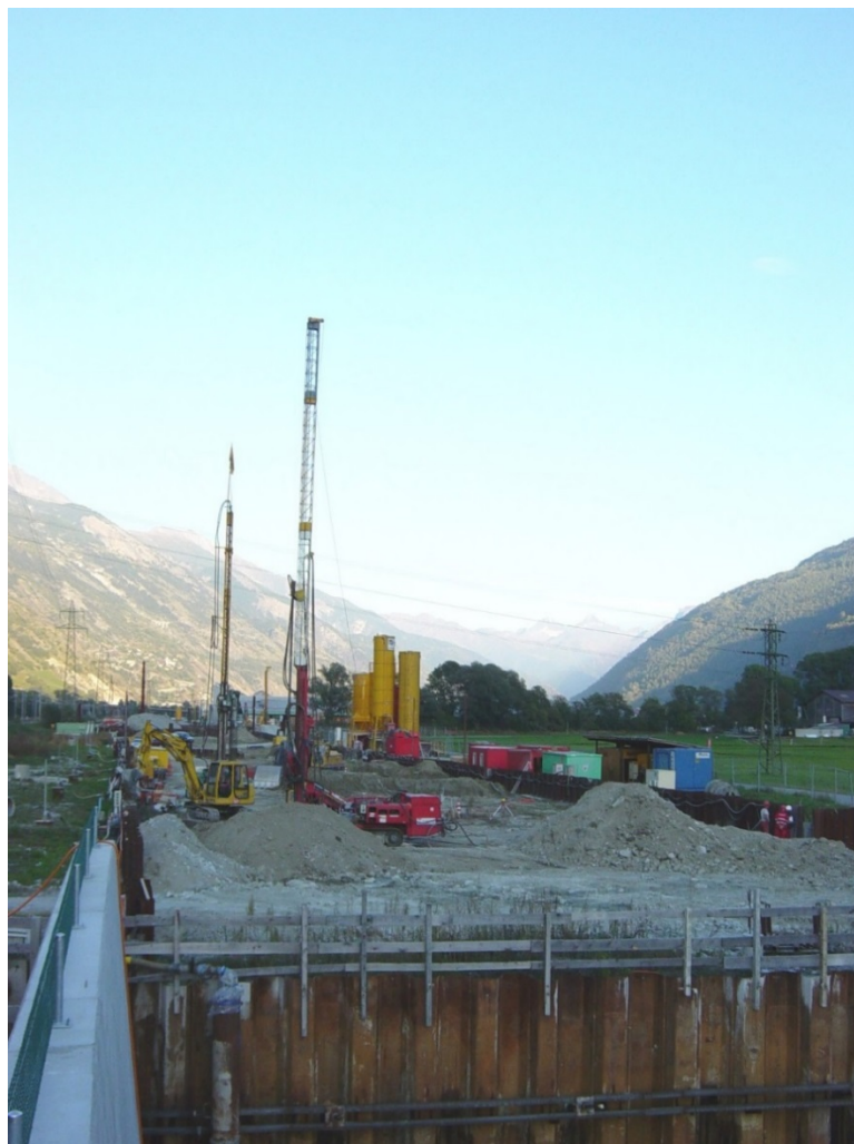
Abbildung 13: Bohrgeräte Casagrande C6 und C8 mit 14m langen Bohrlafetten
