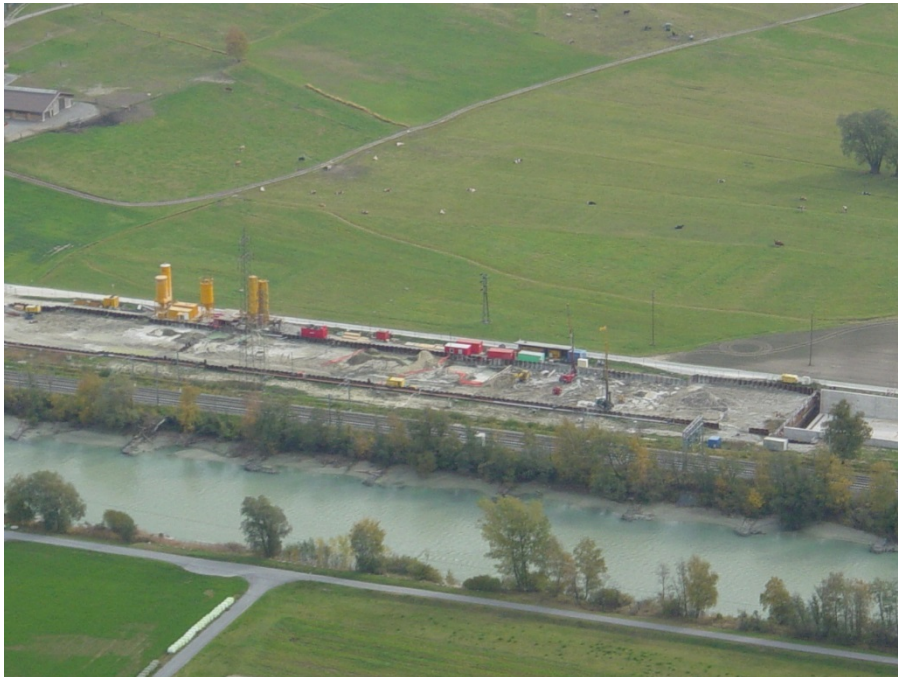
Abbildung 7: Blick auf die Baustelle mit 2 Jetting - Einheiten
