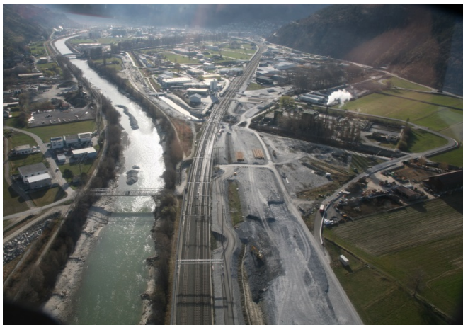
Bild 1: Baustelle Grosseya: Zustand vor Baubeginn, nach Vorschüttung
