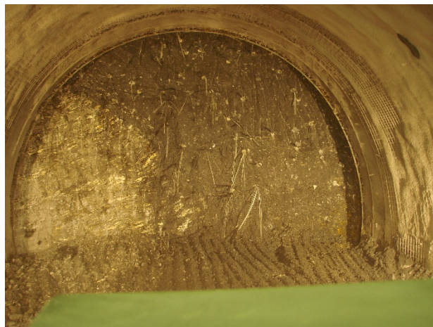
Figure 5: Photo de front mixte rocher - terrain meuble dans la région de Grosshüs.
