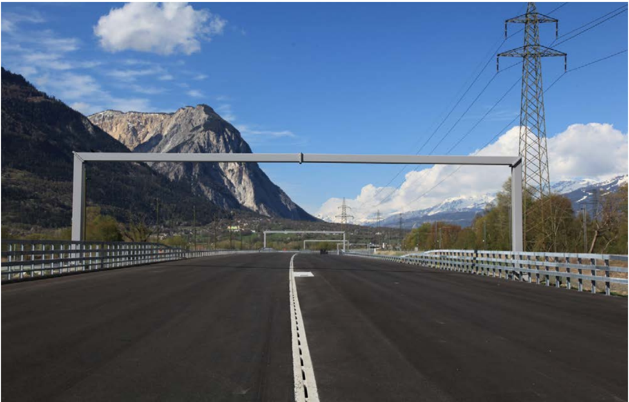
Bild 1: Strecke zwischen Leuk/Susten Ost und Steg/Gampel Ost, welche am 25. November 2016 eröffnet wird.
