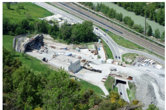
Bild 21: Tunnel Eyholz Portal Grosshüs
