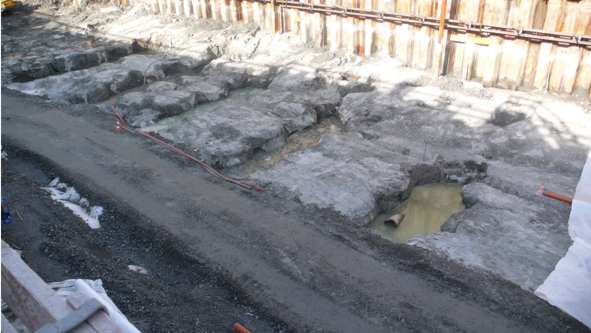
Abbildung 21: Photo der freigelegten Säulen vom 11. Oktober 2008
