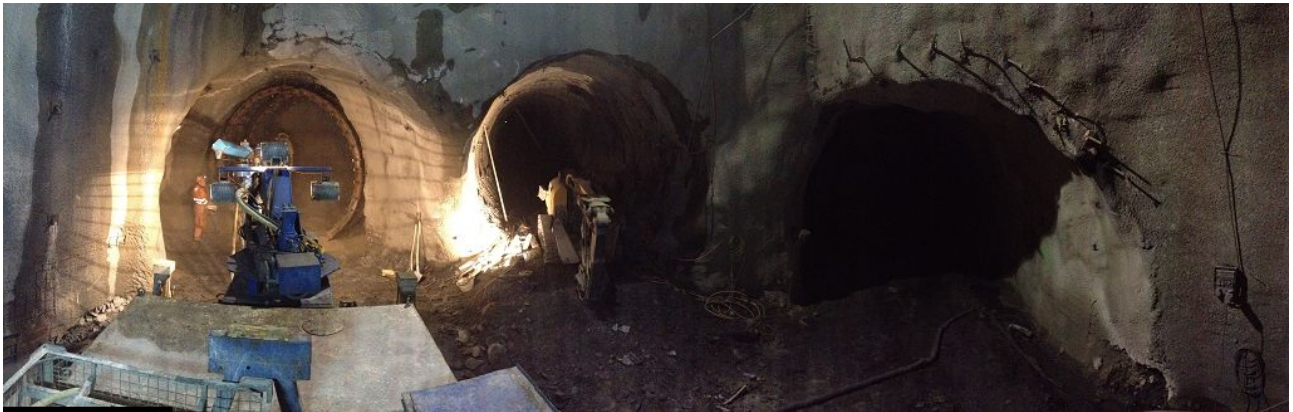
Bild 19: Bau des Widerlagerstollens zum Durchdringen der Störzone im Tunnel Visp, Juni 2015
