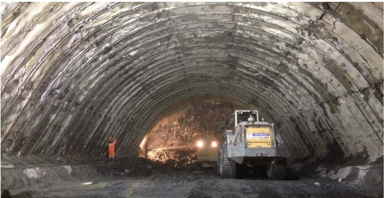
Bild 10: Vortrieb in der Kalotte der Verzweigung VZW I, Bogenausbau mit Deformationselemente
