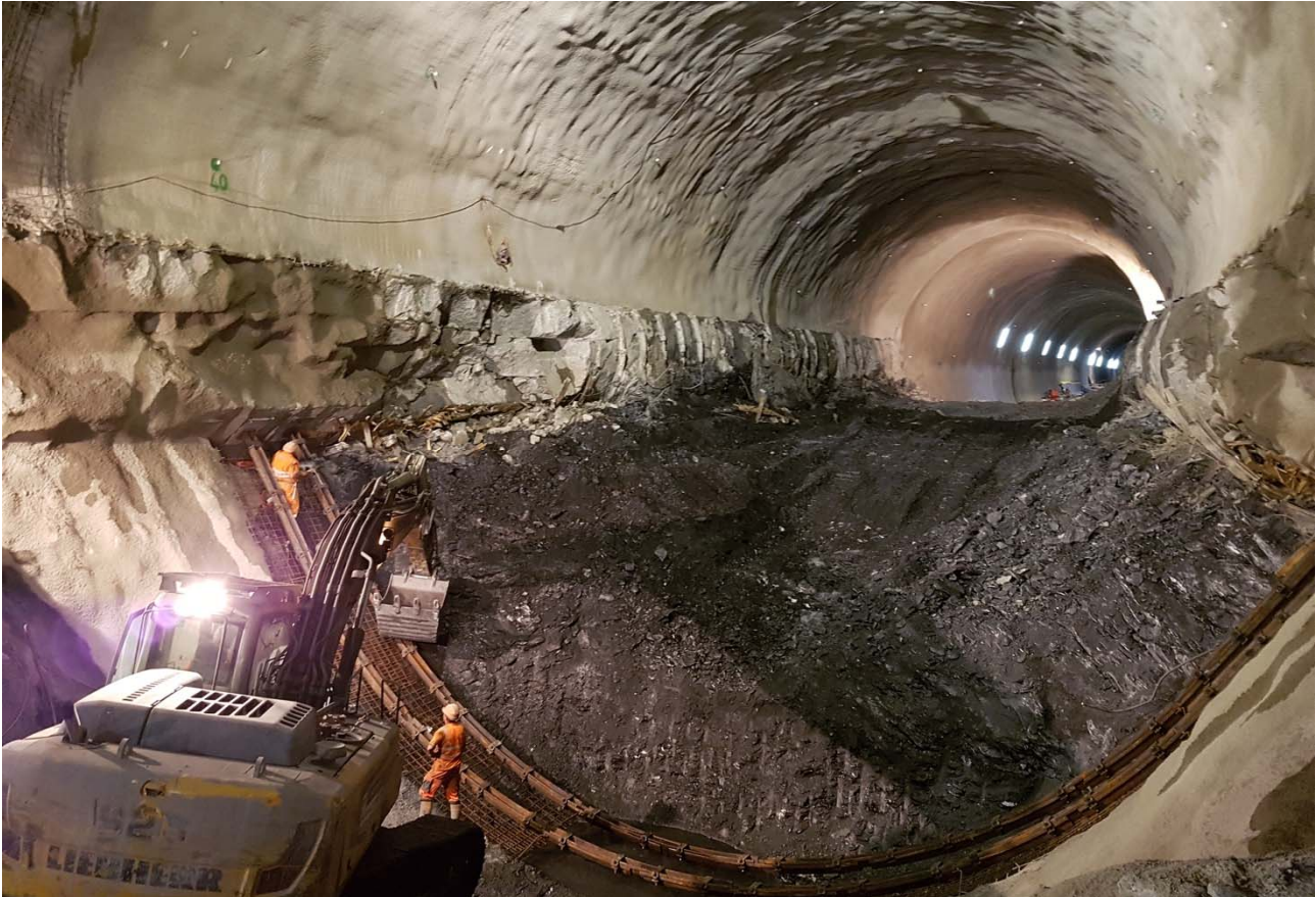
Bild 11: Kavernenausbruch in der Sohle für den Ringschluss in der Störzone der VZW I, Widerlagerstollen im Parament erkennbar.
