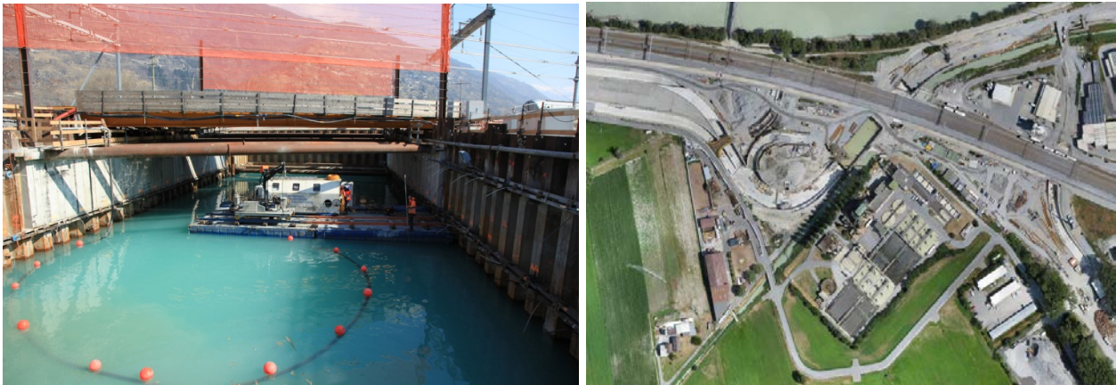
Bild 14: Vollanschluss Visp West: Baustelle im Grundwasser mit Unterwasserbeton, Unterquerung der Geleise, April 2015
