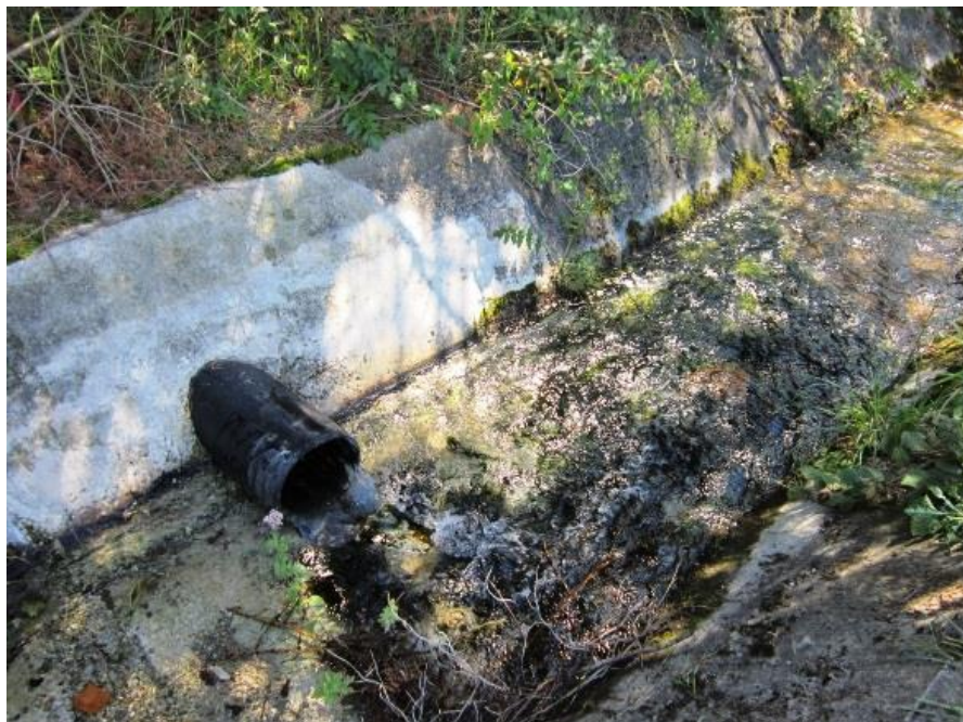
Figure 2 : Exutoire QD-2 (Photo BEG SA, le 09 août 2012).
