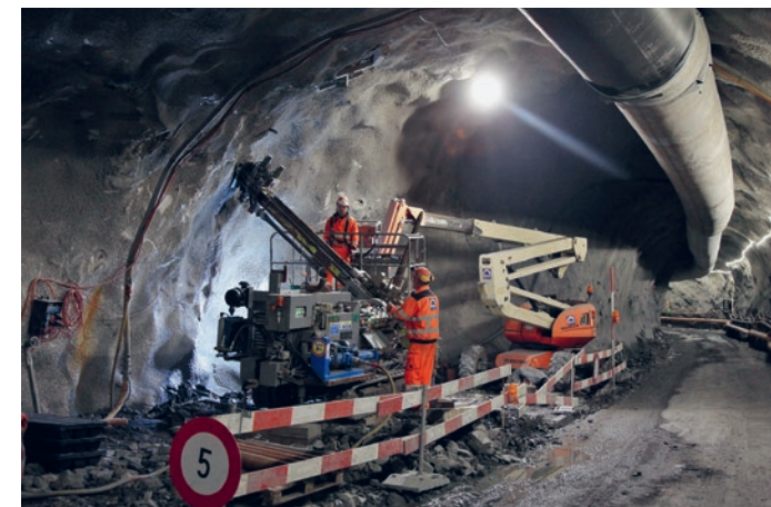
Der bereits zur Hälfte ausgebrochene Erkundungs- und Entwässerungstollen dient der Hangstabilisierung. Je nach Abschnitt beträgt die Steigung 2 bis 12 %.
