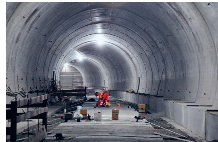
Südröhre des Riedberg-tunnels: die Elemente des Werkleitungskanals sind eingebaut, der Tunnel vollständig betoniert. Das Trasseee wird demnächst zum Asphaltieren vorbereitet.
