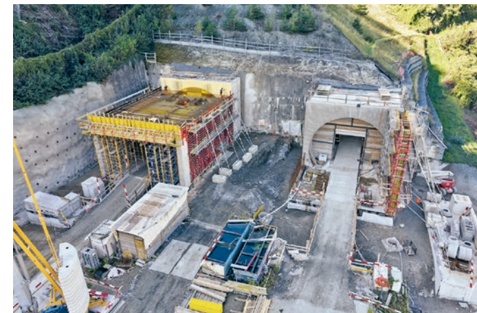
Portalbauwerk im Osten des Riedberg-tunnels. Anschliessend folgt das Trasseee.
