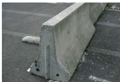
Fig. 65 : Éléments de parois de protection mobiles en béton (Wikipedia).
