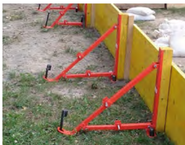
Consolidation avec des supports de coffrage réglables, issus du secteur du bâtiment
