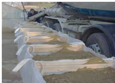
Fig. 64 : Remplissage de sacs de grande capacité renforcés avec un camion malaxeur (INN-PACK)
