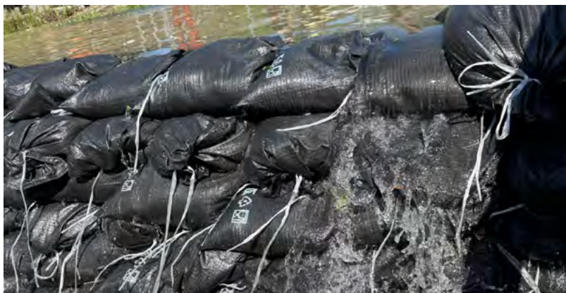
Fig. 41 : Digue de sacs de sable débordée (OFFPP)
