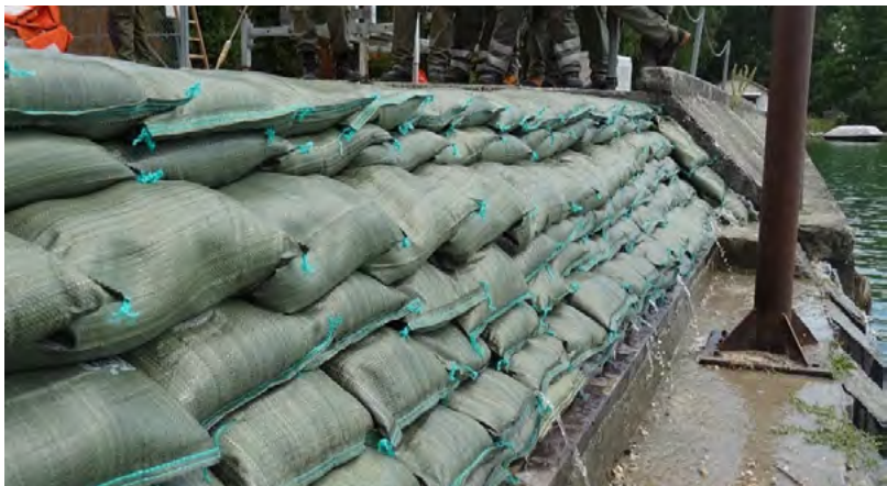
Fig. 48 : Exemple d'une digue réglementaire (OFPP)
