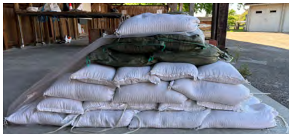
Fig. 47 : Montage d'une digue normale (OFPP)
