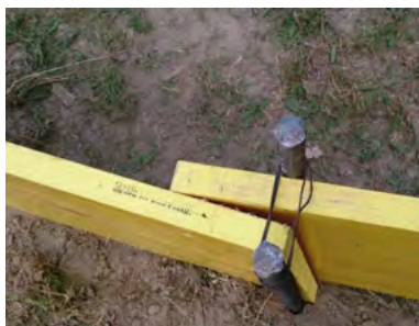
Sécurisation des fers d'armature par du fil torsadé
