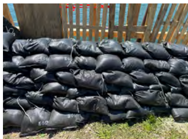
Fig.22 : Système de sacs de sable (OFPP)
