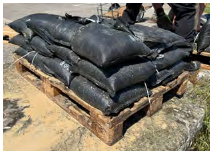
Fig. 52 : Mise à disposition de sacs de sable sur des palettes Europe (THW & OFPP)
