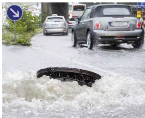
Fig.14 : Reflux par les égouts (Bruno Gerber, Office des ponts et chaussées du canton de Berne)
