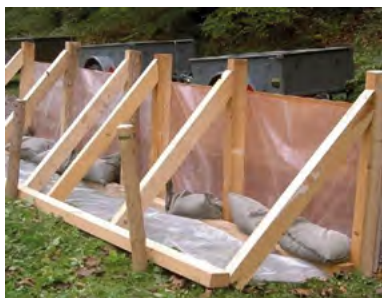
Étalement supplémentaire par du bois équerri
