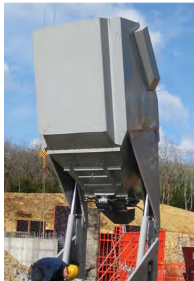
Fig. 38 : Silo de transbordement (BAKO AG)
